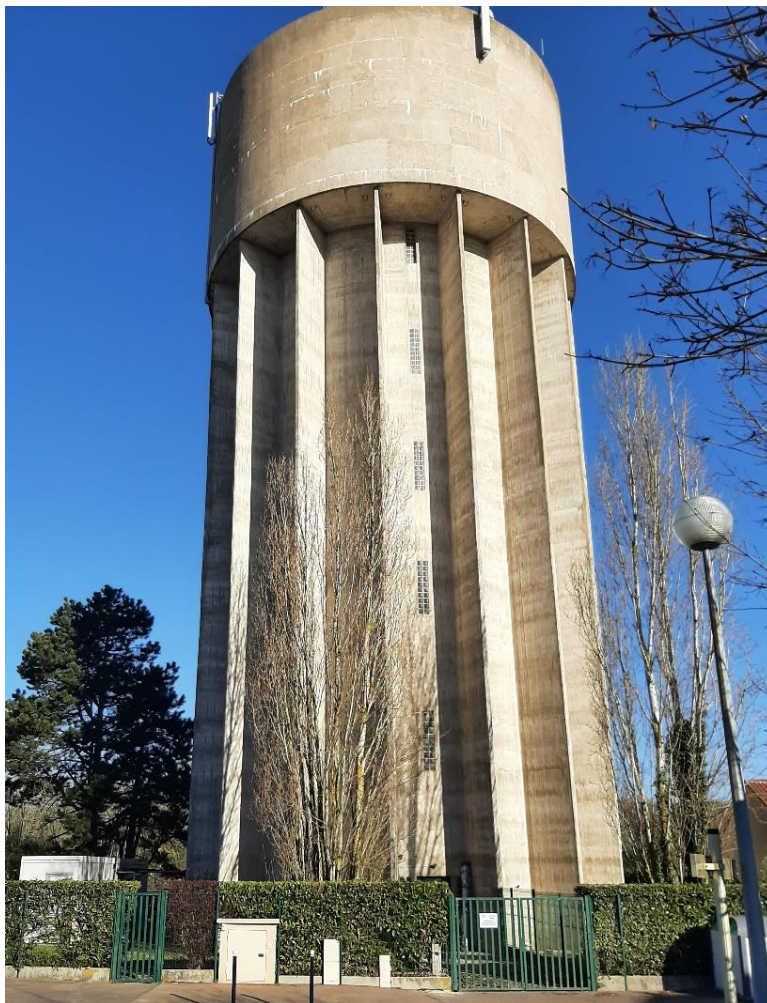
Le château d'eau de Paron
